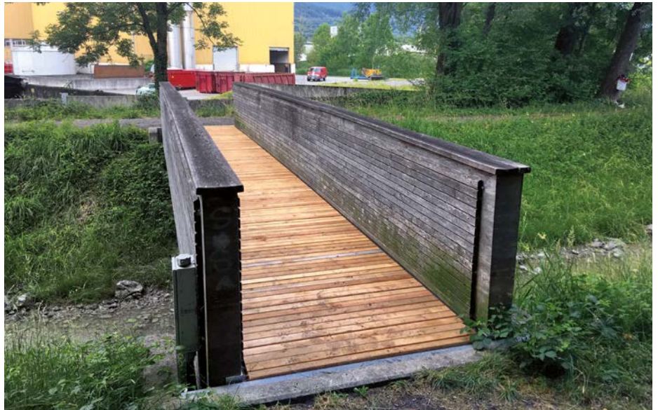
Neue Fußgängerbrücke beim Ratzbach
